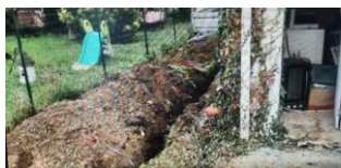
Travaux au presbytère pour colmater la fuite d'eau.
