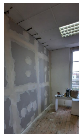
Travaux au 2 e étage locaux annexes
